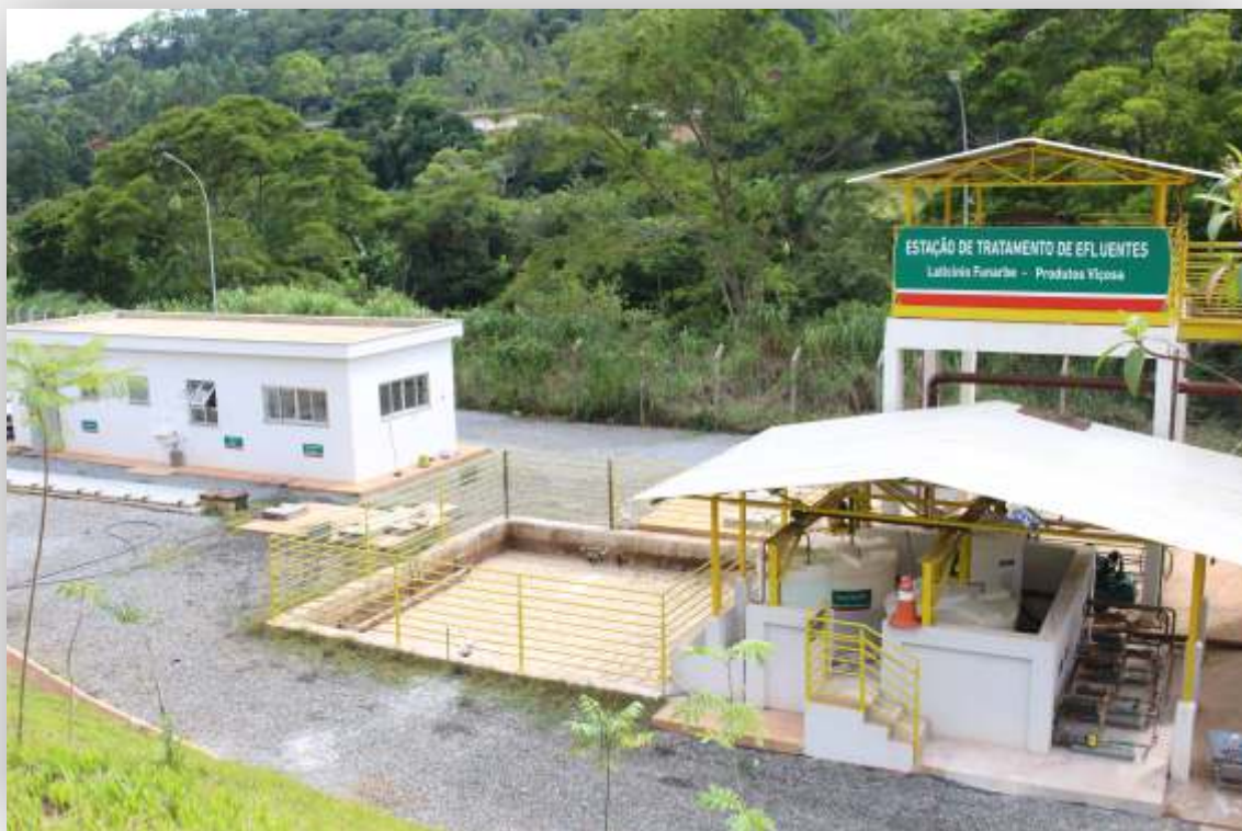
Estação de tratamento de efluentes (ETE).
