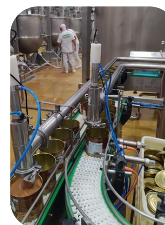
Upgrade da linha de envase e instalação do 2º Sistema de dosagem
